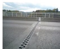
Fürstenland Viadukt, CH
