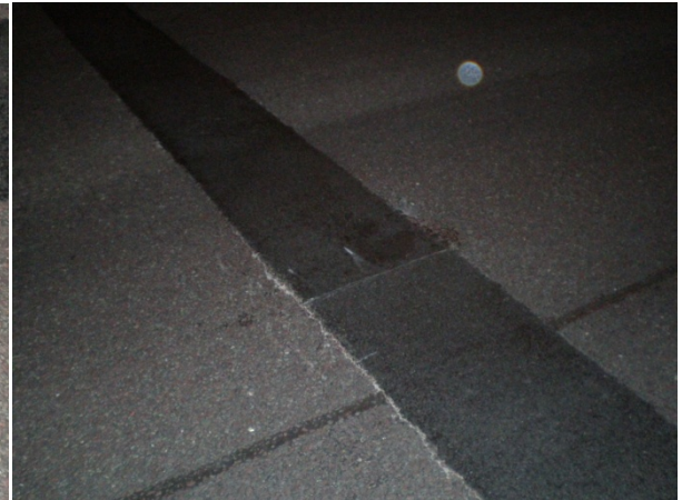
Foto 5.8 Lokaal voegmassa uitgereden
