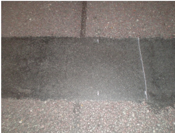
Foto 5.5 Lokaal voegmassa uitgereden
