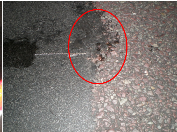
Foto 5.4 Lokaal voegmassa uitgereden
