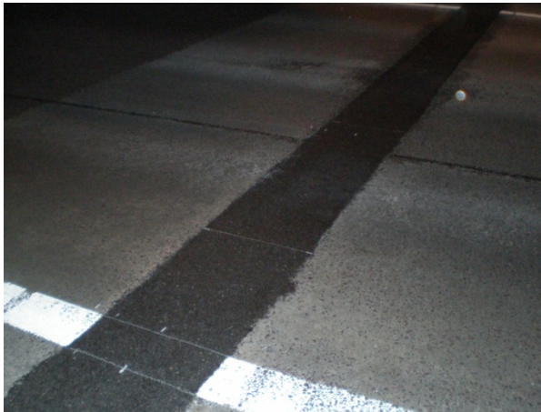
Foto 5.9 Lokaal voegmateriaal uitgereden
