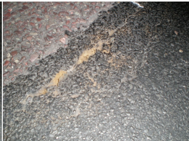
Foto 5.17 detail ingezoomd (lengte scheur 10-15 cm)
