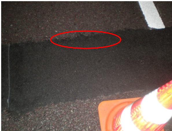
Foto 5.3 Lokaal voegmassa uitgereden
