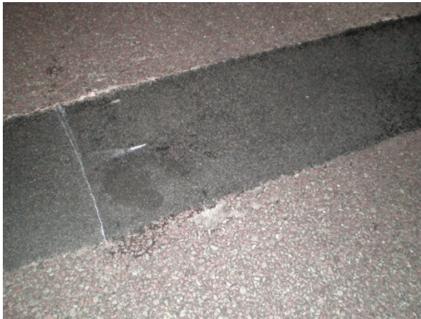
Foto 5.7 Lokaal voegmassa uitgereden
