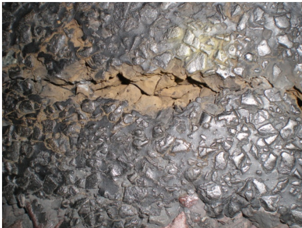
Foto 5.18 Nog meer detail schade Voeler ging circa 2 cm diep
