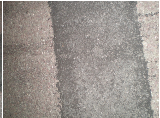
Foto 5.6 Lokaal voegmassa uitgereden
